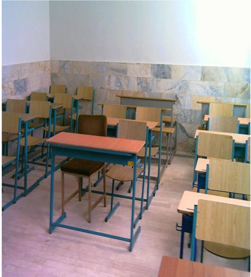
● دیوارهای کلاسهای باید کاملاً خشک ، بدون درز، صاف و حداقل تارتفاع کف پنجره ها از سنگ مناسب استفاده شده و بقیه سطح دیوار مطابق با جدول رنگ فضاهای آموزش وجوداول نازک کاری رنگ آمیزی گردد. و تمهیدات لازم جهت جلوگیری از انتقال صوت به کلاس مجاور انجام شود.
